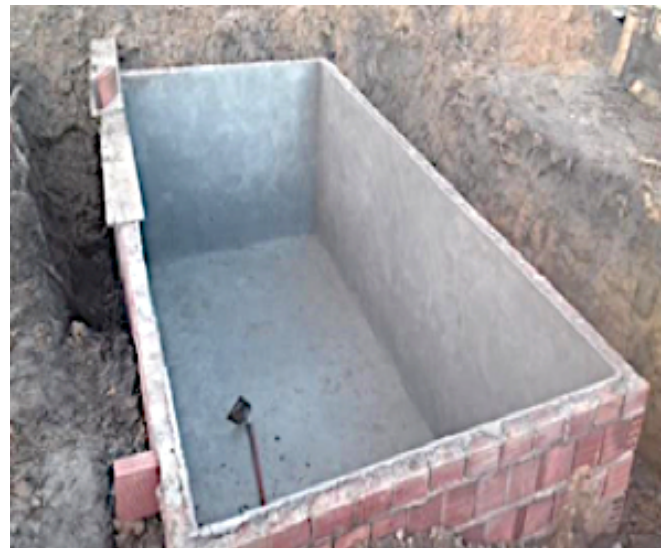
Figura 6. Impermeabilização de Tévap em Chã de Camila, PE, Brasil.
