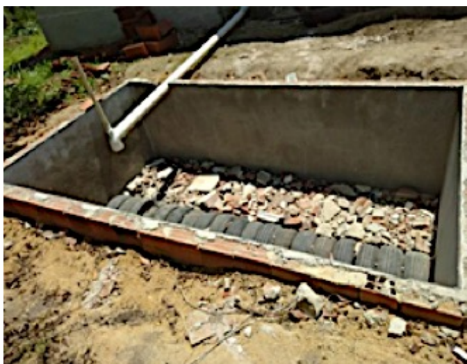
Figura 8. Preenchimento de Tevap com metralha da construção civil em Chã de Camila, PE, Brasil.
