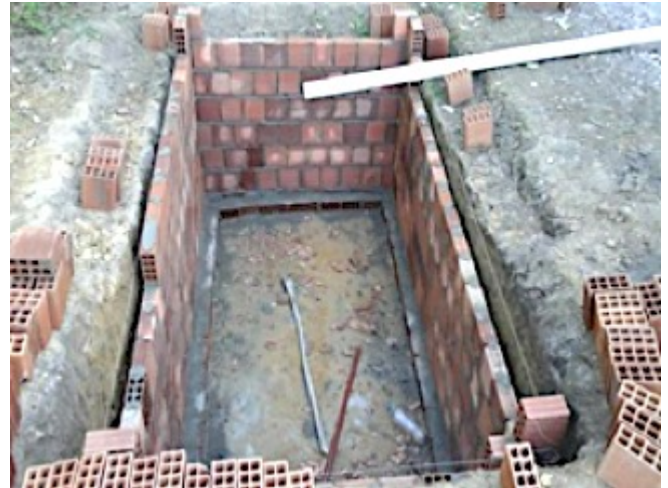
Figura 5. Início da construção de Tévap em Chã de Camila, PE, Brasil.
