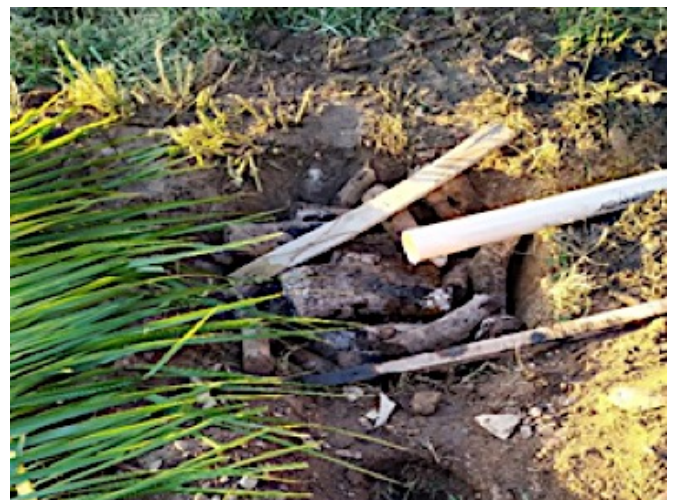
Figura 14 Preenchimento com troncos e ramos e inserção do cano de águas cinzas no Círculo de Bananeira.
