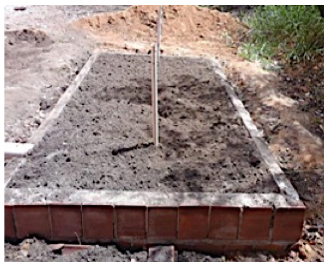
Figura 11. Colocação do solo no Tevap em Chã de Camila, PE, Brasil.
