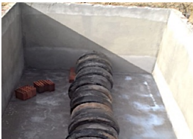
Figura 7. Colocação de pneus para fazer a câmara de fermentação em Chã de Camila, PE, Brasil.
